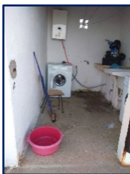
Fig4. Zona de colada. .Fuente: Huelva Acoge (2017).
